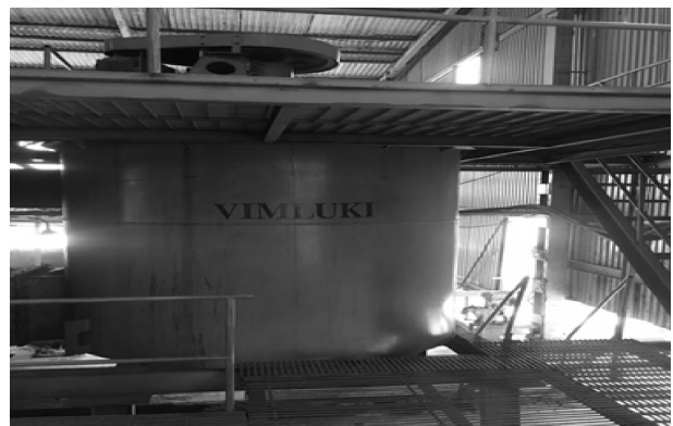
Hình 10. Thiết bị tuyển nổi tankcell 8 m 3 chế tạo được lắp đặt tại dây chuyền tuyển nổi chì kẽm Chợ Điền, tỉnh Bắc Kạn
